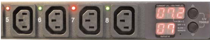
Arrière d'une PDU 1U présentant le courant utilisé par la prise 7. Les LED rouges correspondent aux prises sous tension. Les témoins verts correspondent aux prises hors tension.
